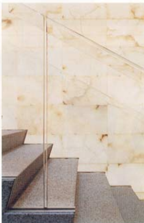
Design Entreprise ; à droite, garde-corps en verre extra blanc, feuilleté avec main courante en surépaisseur polie.
