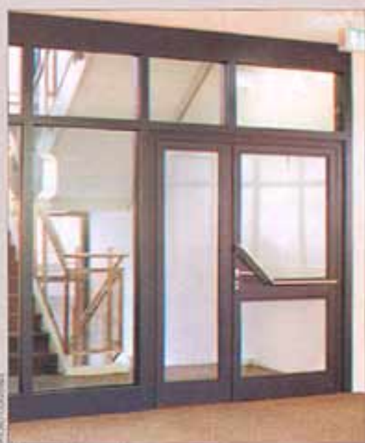
Un escalier protégé.
