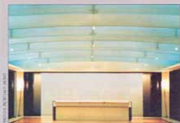
Hall du siège social Vuitton : plafond avec poutres en verre feuilleté.
