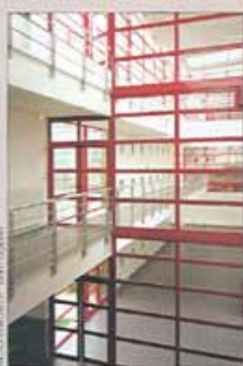
Une cloison vitrée P-F 1/2 heure pour ce collège à Ermont.
