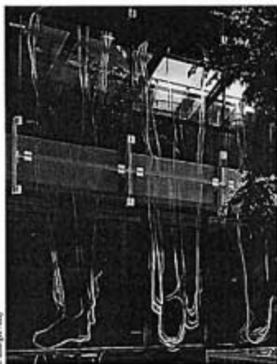
Décoration et confort visuel : façade écran verre feuilleté et gravé, verre feuilleté avec filins intercalaires colorés, verre émaillé rue intérieure, université Léonard-de-Vinci (Paris-La Défense), architectes Valode et Pistre, création Jean-Charles Blais, conception et réalisation verrières Bernard Pictet
