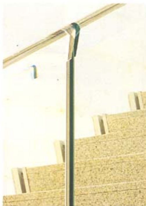
Le Palais des Congrès de Vichy (Michaël Prentice, sculpteur et J-G. de Castelbajac, architecte) : le garde-corps avec sa main courante entièrement réalisé en verre (procédé mis au point par Bernard Pictet) et donc parfaitement transparent, scintillant sur un fond constitué par un mur en albâtre. If The Vichy congress centre (Michael Prentice, sculptor, and J-G. de Castelbajac, architect) : the parapet with its handrail, completely made of glass (process perfected by Bernard Pictet), and therefore perfectly transparent, glittering against the background formed by an alabaster wall. (Photos Jean-Marie Monhiers)
