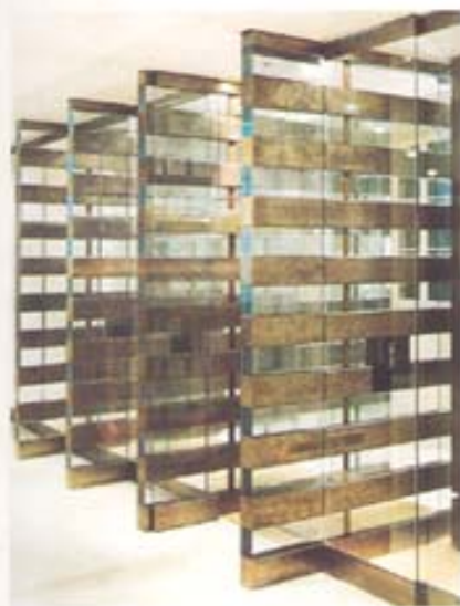
Détail du hall du siège de la CGE (agence Grenot, Kubicki architecte) avec ses cloisonnements où le verre lamellé-collé intervient comme élément structural tout en intégrant un radar, sous la houlette de Bernard Pictet, verrier. If Detail of the hall of the CGE offices (Grenot, Kubicki architectural practice) where the laminated dividing wall, intervenes as a structural element, while integrating a radar, realised with the aid of the expertise of glassmaker Bernard Pictet. (Photo M. Pignata Mem)
