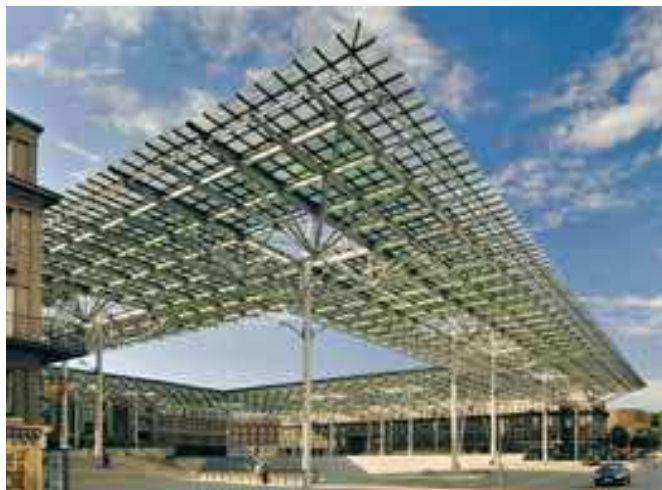
700 tonnes de charpente métallique et 1.300 tonnes de vitrages feuilletés ont été nécessaires à la construction de la verrière.
