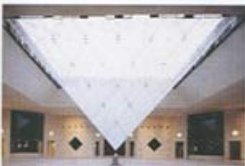
C'est la société italienne Siv qui a fourni les plaques, coupées et percées, les a récupérées après la stratification pour effectuer le biseautage de chacun des éléments. Les 4 poutres qui forment la base de la toiture étanche (pesant 80 tonnes) ne soutiennent en effet en toiture pas moins de 84 éléments verriers de forme carrée et 28 éléments triangulaires en VEC. Ces éléments sont reliés entre eux par des barrettes métalliques accrochées à un réseau
